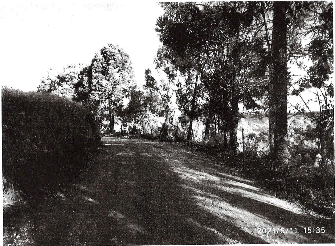
FOTO 2 – MEIO DA VIA
