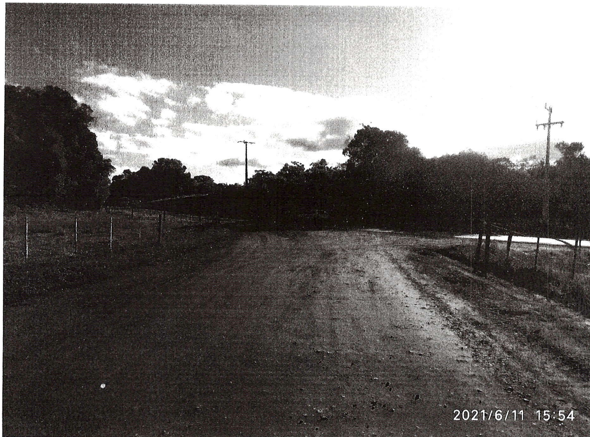
FOTO 1 – INÍCIO DA VIA
