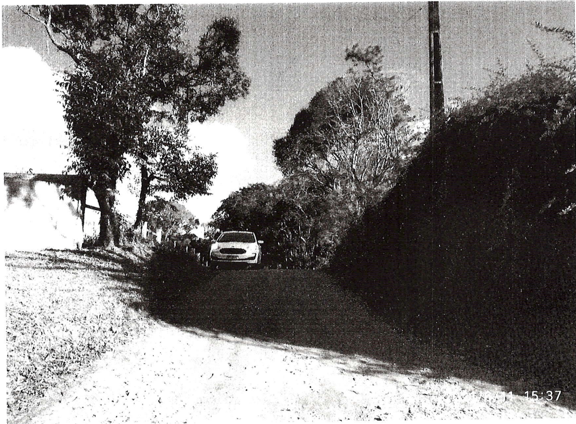
FOTO 1 – INÍCIO DA VIA
