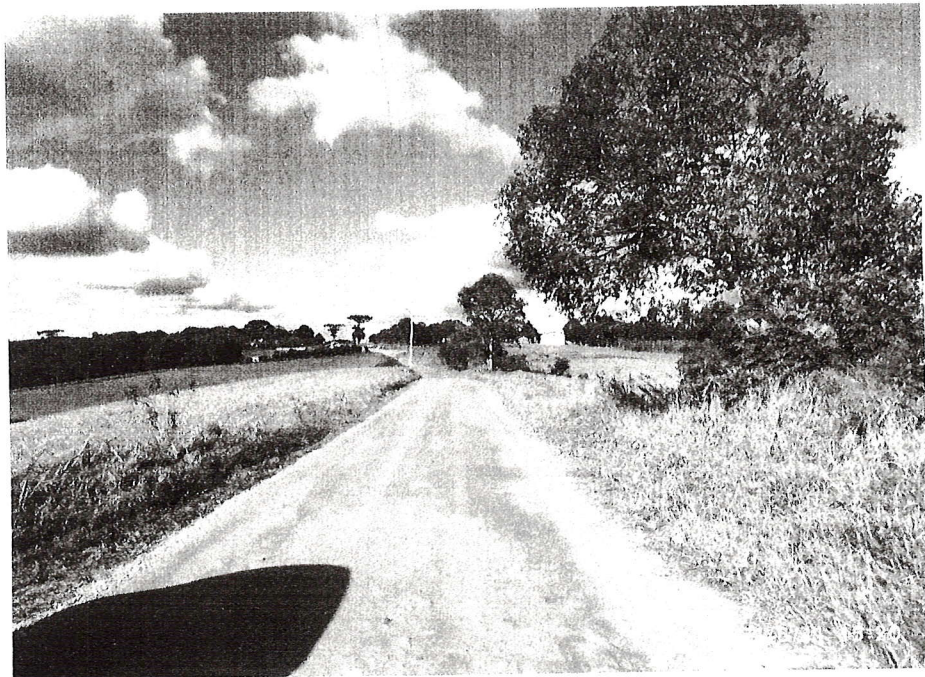
FOTO 3- MEIO DO TRECHO DA VIA
