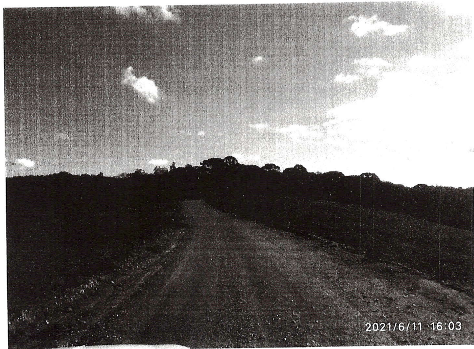
FOTO 2 – MEIO DO TRECHO DA VIA
