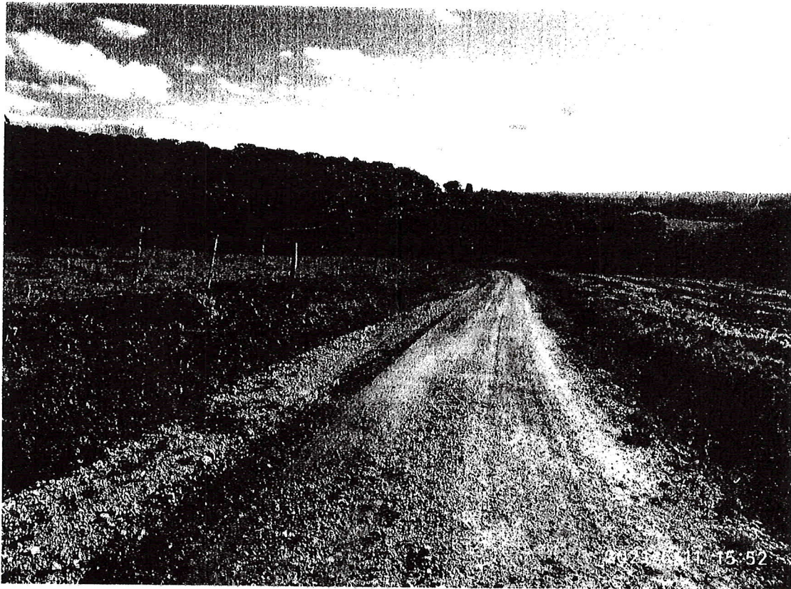
FOTO 2 – MEIO DA VIA
